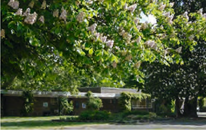
Neuer Haupteingang an der Garkenburgstraße
