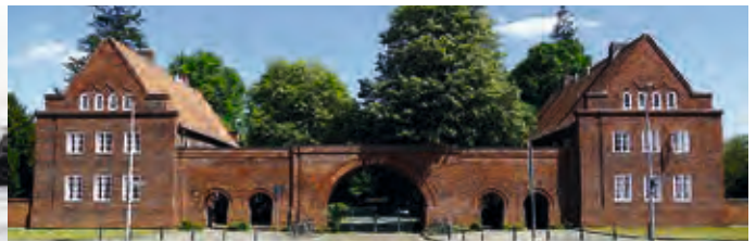
Gebäude am Eingang Hoher Weg im Jahre 2020
