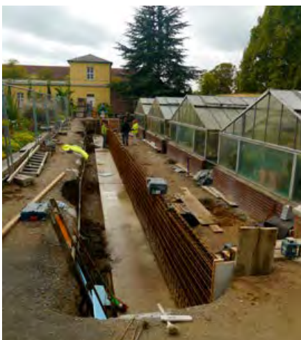
Mauersanierung im Schmuckhof des Berggartens
