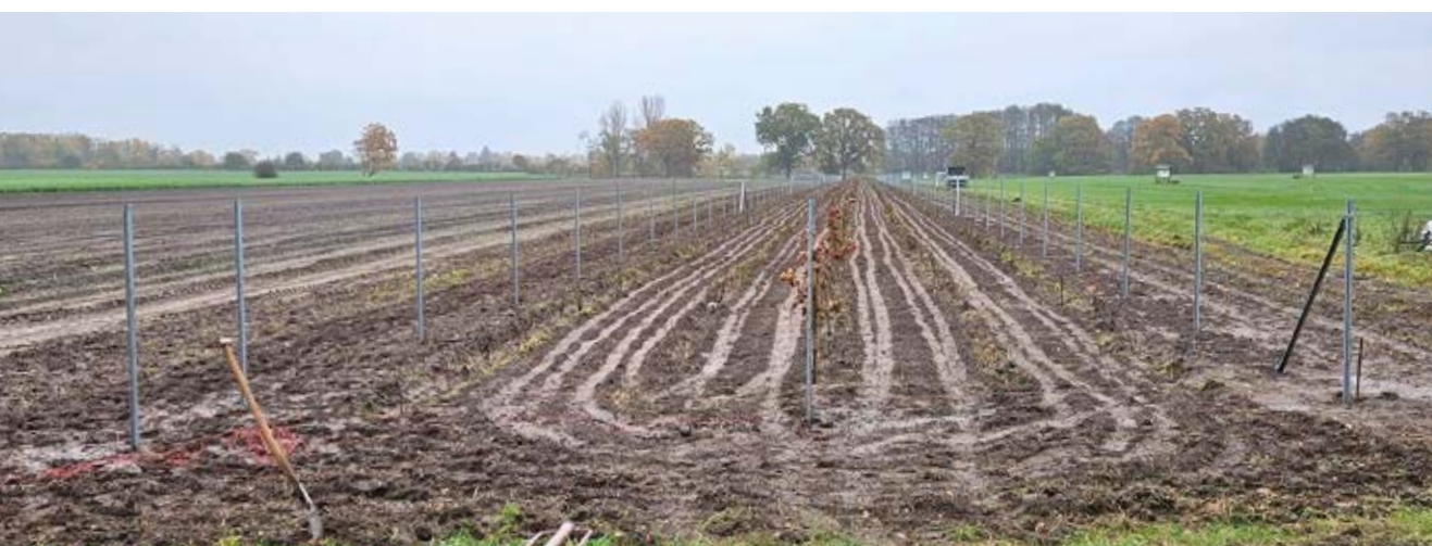
Die Fläche nach der fertigen Pflanzung und dem Zaunbau.
