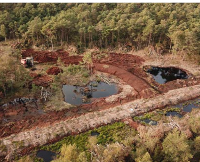
Moorbagger bei der Damerrichtung, nordwestliches Bissendorfer Moor, September 2023
