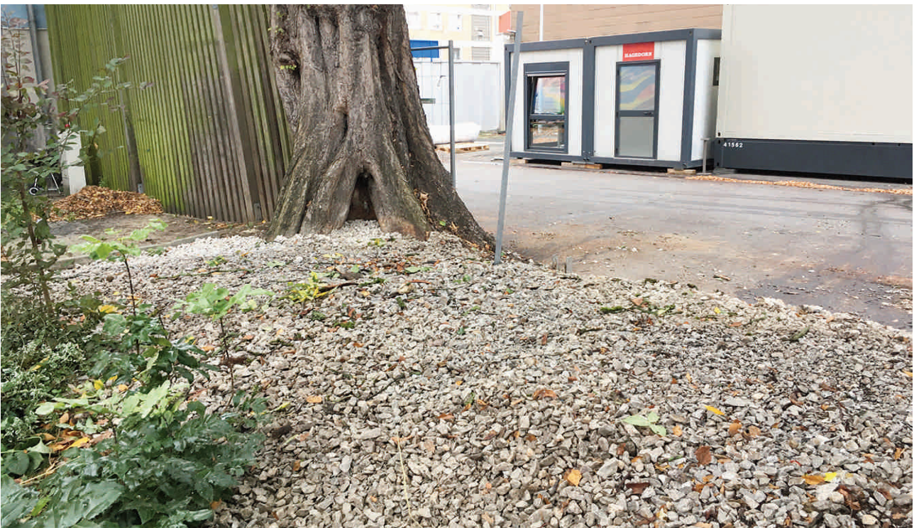
Abbildung 20: BV E-Damm Neubau; Engelbostler Damm, 30167 Hannover; Wurzelerkundungen beim sachgegenständlichen Ulmen-Altbaumes (Grenzbaum) auf dem Nachbargrundstück (Gundlach); Abdeckung der freigelegten Wurzelarchitektur durch Mineralstoffgemisch auf dem Nachbargrundstück (Gundlach) nach Untersuchungsabschluss; Blickrichtung Ost.
