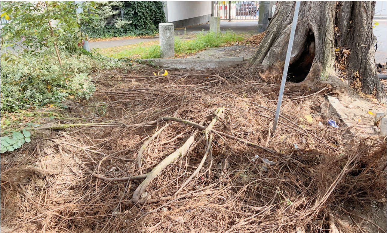
Abbildung 16: BV E-Damm Neubau; Engelbostler Damm, 30167 Hannover; Wurzelerkundungen beim sachgegenständlichen Ulmen-Altbaumes (Grenzbaum) auf dem Nachbargrundstück (Gundlach); freigelegte oberflächenzonal ausgebildete Wurzelarchitektur auf dem Nachbargrundstück; Blickrichtung Ost.
