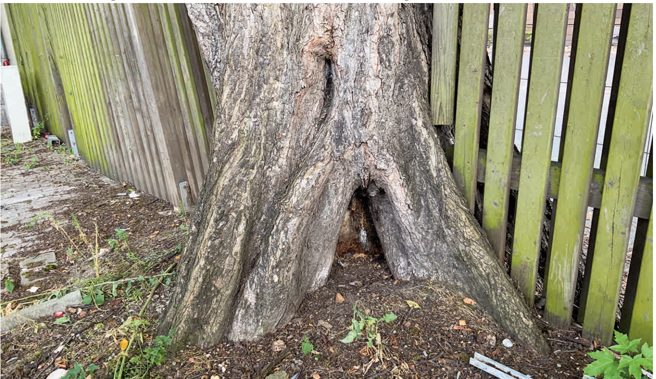
Abbildung 8: BV E-Damm Neubau; Engelbostler Damm, 30167 Hannover; Standfuß mit Höhlung und Kernfäule zwischen den Wurzelanläufen im südlichen Entwicklungsraum des sachgegenständlichen Ulmen-Altbaumes (Grenzbaum) auf dem Nachbargrundstück (Gundlach) zum Zeitpunkt der Inaugenscheinnahme am 21.07.2021; Blickrichtung Ost.
