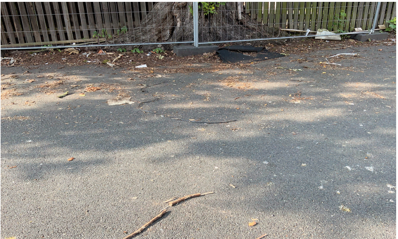
Abbildung 4: BV E-Damm Neubau; Engelbostler Damm, 30167 Hannover; Nördlicher Stand- und Entwicklungsraum des sachgegenständlichen Ulmen-Altbaumes (Grenzbaum) auf dem Werksgelände vormals Fa. Bumke; der südliche Stand- und Entwicklungsraum ist durch eine Asphaltdecke vollständig versiegelt; Blickrichtung Süd.
