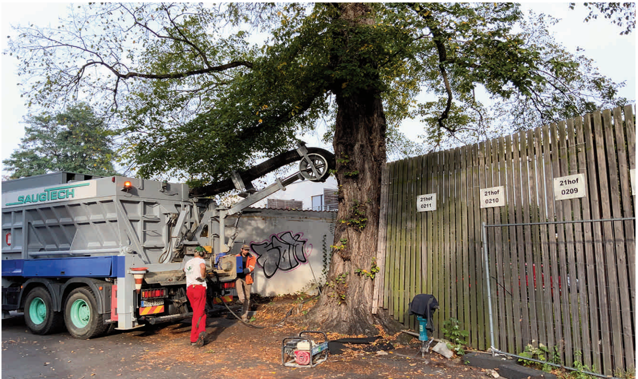
Abbildung 9: BV E-Damm Neubau; Engelbostler Damm, 30167 Hannover; Wurzelerkundungen beim sachgegenständlichen Ulmen-Altbaumes (Grenzbaum) auf dem Baugelände vormals Werksgelände Fa. Bumke zum Zeitpunkt der Inaugenscheinnahme am 23.09.2021 durch Großsaugtechnik.
