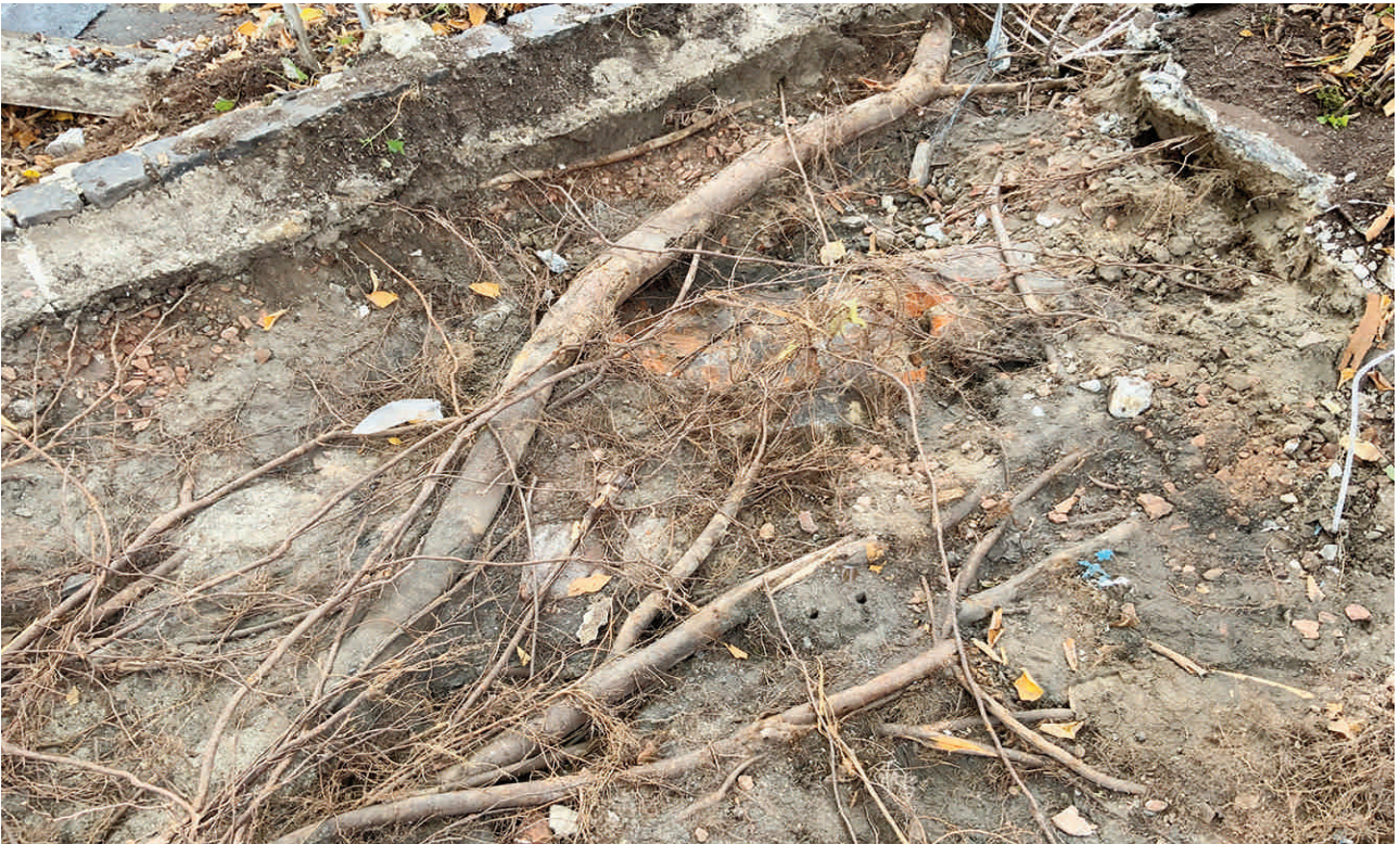
Abbildung 17: BV E-Damm Neubau; Engelbostler Damm, 30167 Hannover; Wurzelerkundungen beim sachgegenständlichen Ulmen-Altbaumes (Grenzbaum) auf dem Nachbargrundstück (Gundlach); freigelegte oberflächenzonal ausgebildete Starkwurzel auf dem Nachbargrundstück die ein Grenzmauerbauwerkfundament erschlossen hat.
