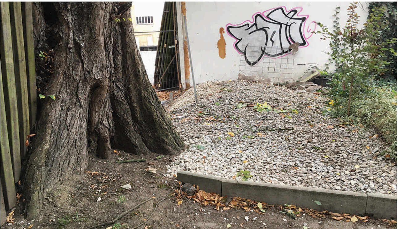
Abbildung 19: BV E-Damm Neubau; Engelbostler Damm, 30167 Hannover; Wurzelerkundungen beim sachgegenständlichen Ulmen-Altbaumes (Grenzbaum) auf dem Nachbargrundstück (Gundlach); Abdeckung der freigelegten Wurzelarchitektur durch Schotterauftrag aus Mineralstoffgemisch nach Untersuchungsabschluss; Blickrichtung West.
