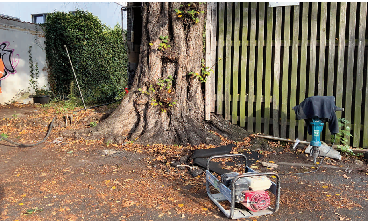
Abbildung 10: BV E-Damm Neubau; Engelbostler Damm, 30167 Hannover; Stemmarbeiten zur Wurzelerkundungen beim sachgegenständlichen Ulmen-Altbaumes (Grenzbaum) in der Asphaltfläche auf dem Baugelände vormals Werksgelände Fa. Bumke zum Zeitpunkt der Inaugenscheinnahme am 23.09.2021 durch Großsaugtechnik.
