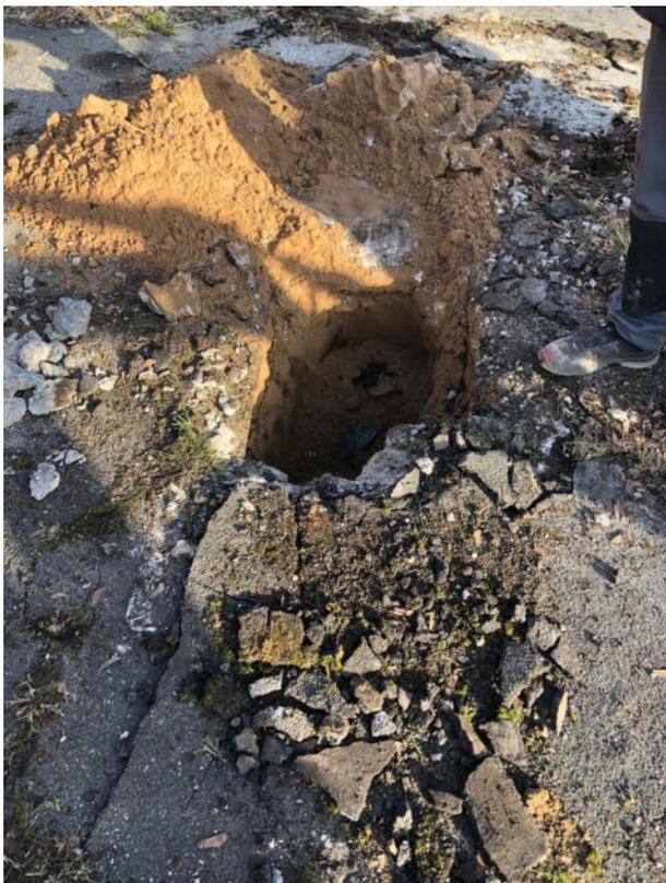
← Abb. 8.: Baggerschurf am Schachtdeckel - kein Domschacht oder Hinweis auf unterirdischen Behälter (Situation am 13. Januar 2022)
