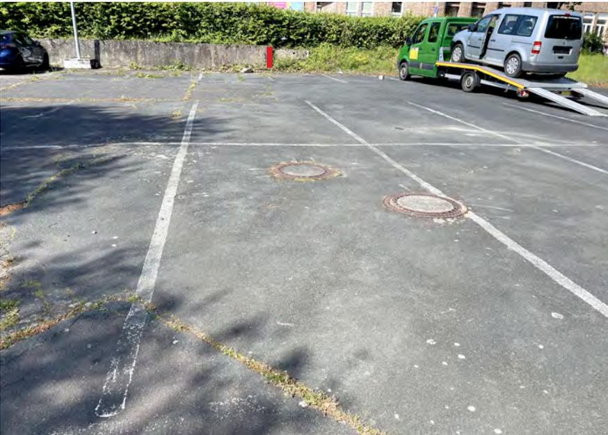
Bild 2: In der Bildmitte vermutlich Schachtdeckel der Regen- und Schmutzwasserleitung aus der Zeit der Tankstellennutzung (Anlage 3). Im Hintergrund (rote Markierung) die Schachtdeckel der Abscheideranlage (H, Anlage 3). Westliche Blickrichtung.
