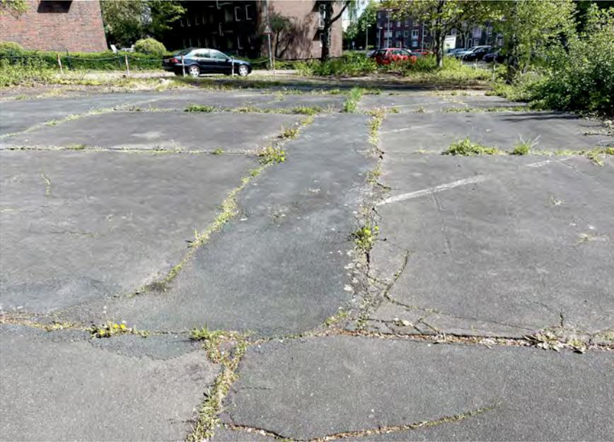
Bild 7: Die ausgebeesserte Asphaltdecke stellt möglicherweise die Lage einer ehemaligen Zapfinsel dar (F, Anlage 3). Blick nach Nordost.
