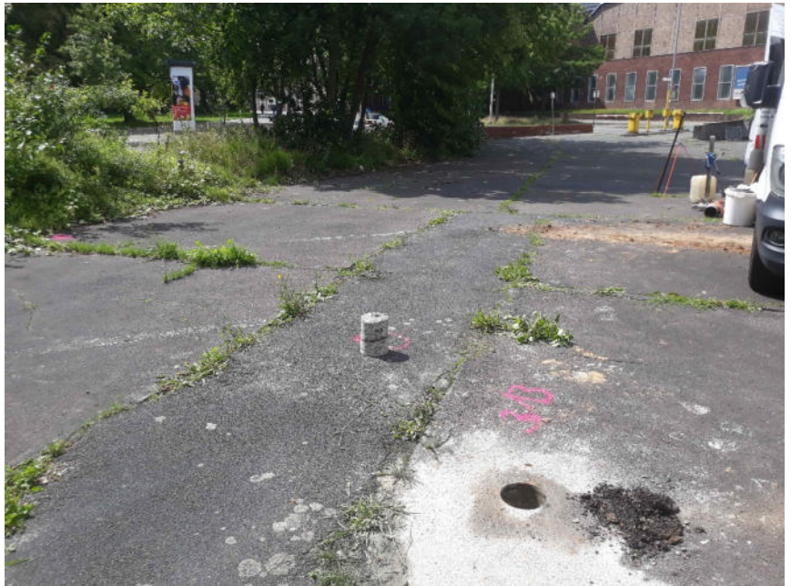
Abb. 9.: Blick auf die Bohrstandorte B 13 und B 17 - Situation am 8. August 2023
