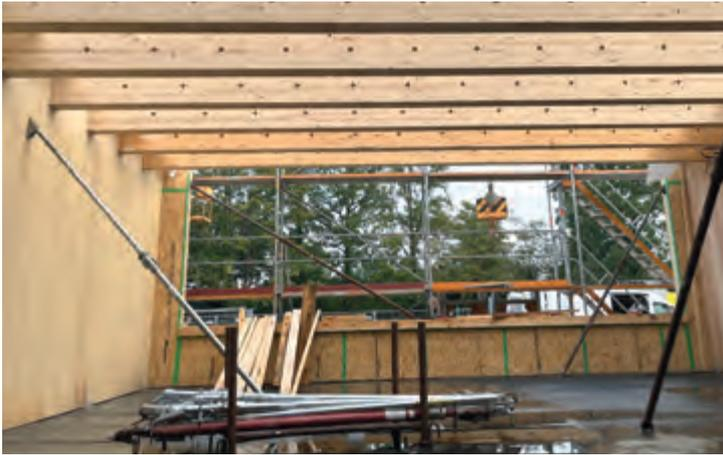
Die gebäudeerweiternde Neubau-Konstruktion wird als Holzrahmenbauweise hergestellt. Das flach geneigte extensive Gründach wird mit einer Photovoltaik-Anlage über dem Bestandsklassentrakt sowie dem Erweiterungsbau ausgerüstet.
