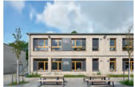
sowie ein teilweiser Innenausbau mit Elektro- und Sanitärinstallation bereits im Werk erbracht wurde. So wurden beinahe vollständig ausgebaute Raummodule auf der Baustelle angeliefert und mussten vor Ort nur noch geringfügig endgefertigt werden.
