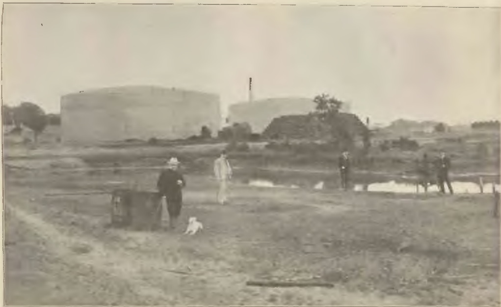
Wallmann'sche Leerkuhle; im Hintergrunde Tankanlage der Maatschappij tot exploitatie van oliebronnen und der Rangier-
