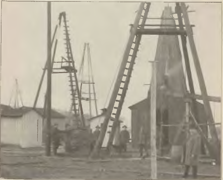
Auf der sogen. Teufelsinsel (Hauptproduktionsgebiet). Rechts: Delpumpe mit Ableitungsröhr, dahinter Bohrturm.
