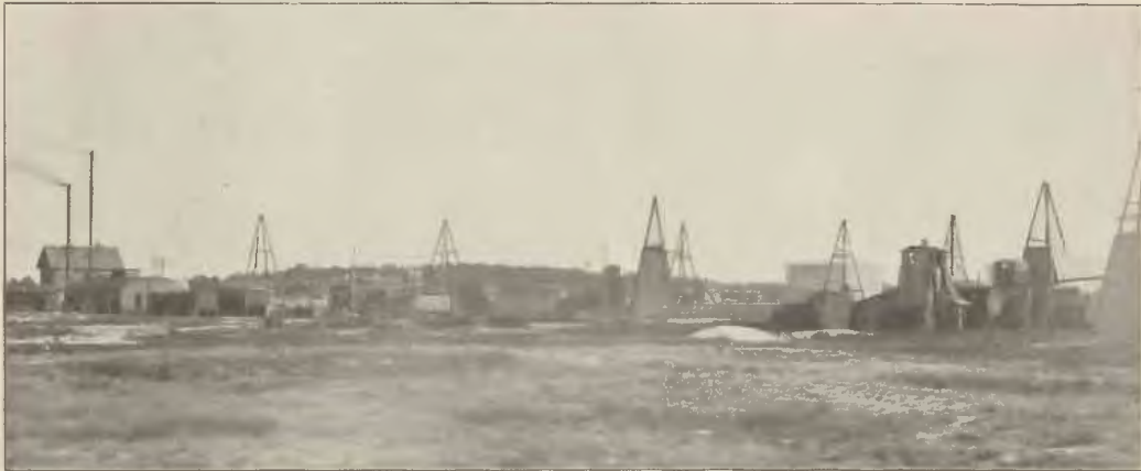
Anlagen im Nordfelde des Oelreviers. Niederländisch-Deutsche Petroleumgesellschaft, dahinter: Tanks der Alt-Ges. Celle-Wiese.
