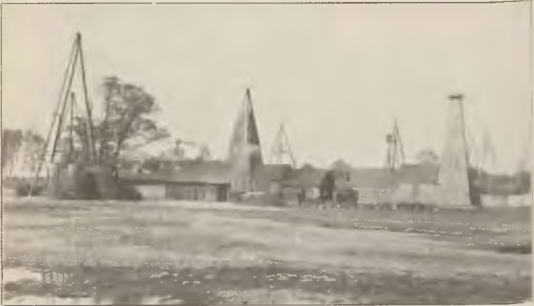
Auf der Teufelsinsel. Bohrungen der Maatschappij tot expl. van oliebronnen (früher Wood).
