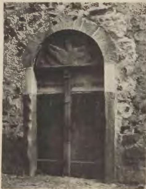
Abb. 5. Westl. Tür an der Kirche zu Lachem b. Hameln. Starke Hohlschliffe am linken Pfosten.
