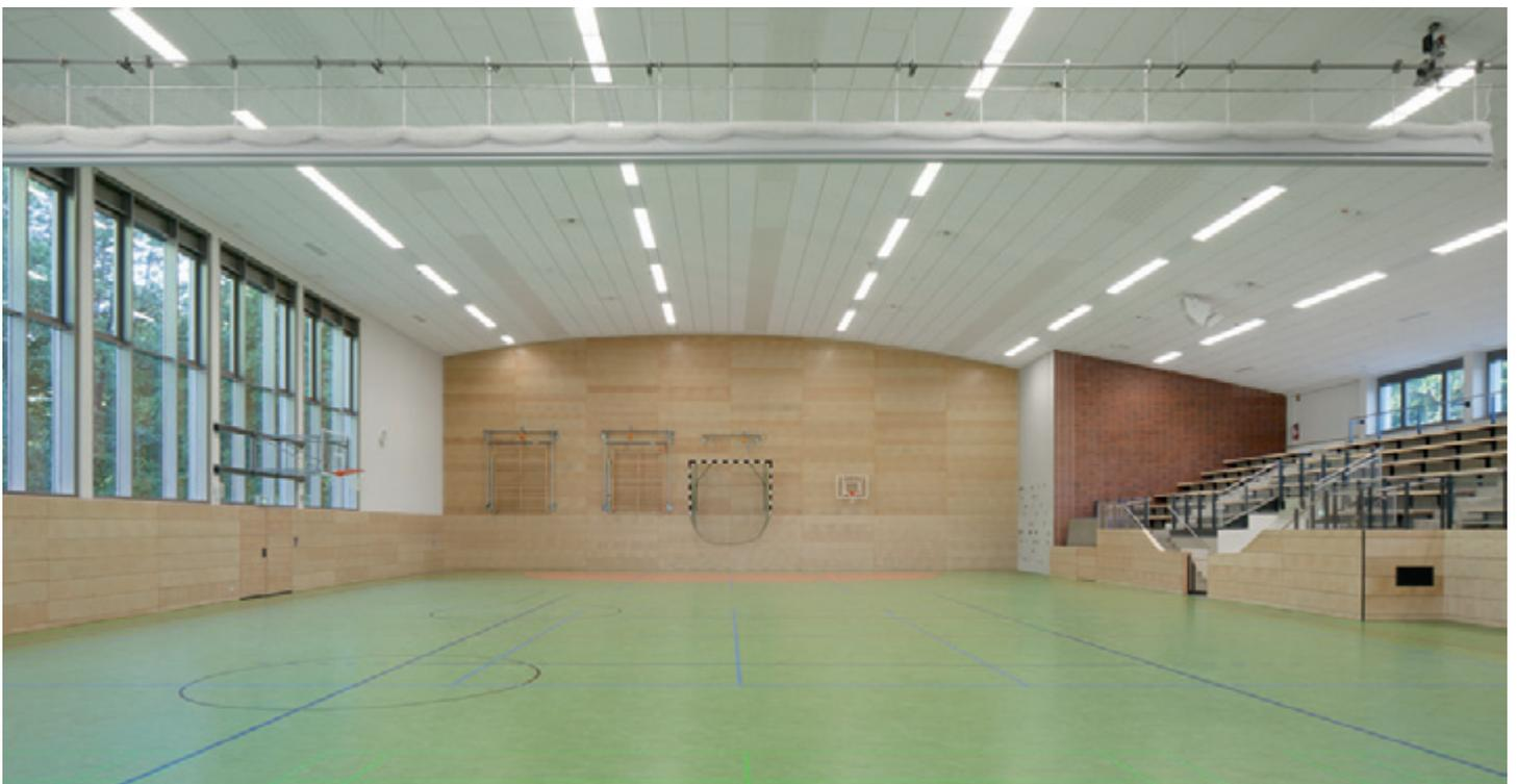
Die große Haupthalle erhielt einen neuen Schwingboden mit Linoleumbelag. Stirn- und Seitenwände wurden mit flächenelastischem Prallschutz aus Holzwerkstoff versehen. Festinstallierte Tore und Gittersprossenwände wurden durch neue, bei Bedarf herabzulassende ersetzt. Vier zusätzliche Basketballkörbe stehen für das Training zur Verfügung. Ein neuer Trennvorhang ermöglicht den Sportbetrieb in 2 separaten Spielfeldern.
