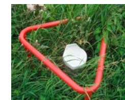
GRUNDWASSERMESSTELLEN IM STADTGEBIET VON HANNOVER
