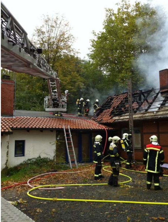
Durchgebranntes Dach des Nebengebäudes (Foto: Feuerwehr Hannover)
