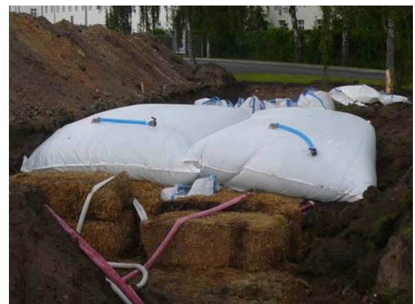
Als Dämmmaterial kamen Flüssigkeitsbehälter zum Einsatz. (Foto: Feuerwehr Hannover)
