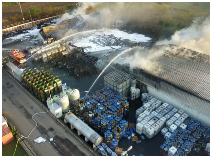
Blick auf das teileingestürzte Fasslager (Foto: Feuerwehr Hannover)
