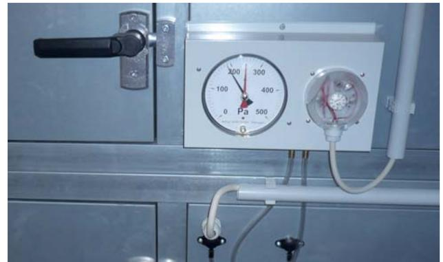
Differenzdruckmessung mit Manometer
