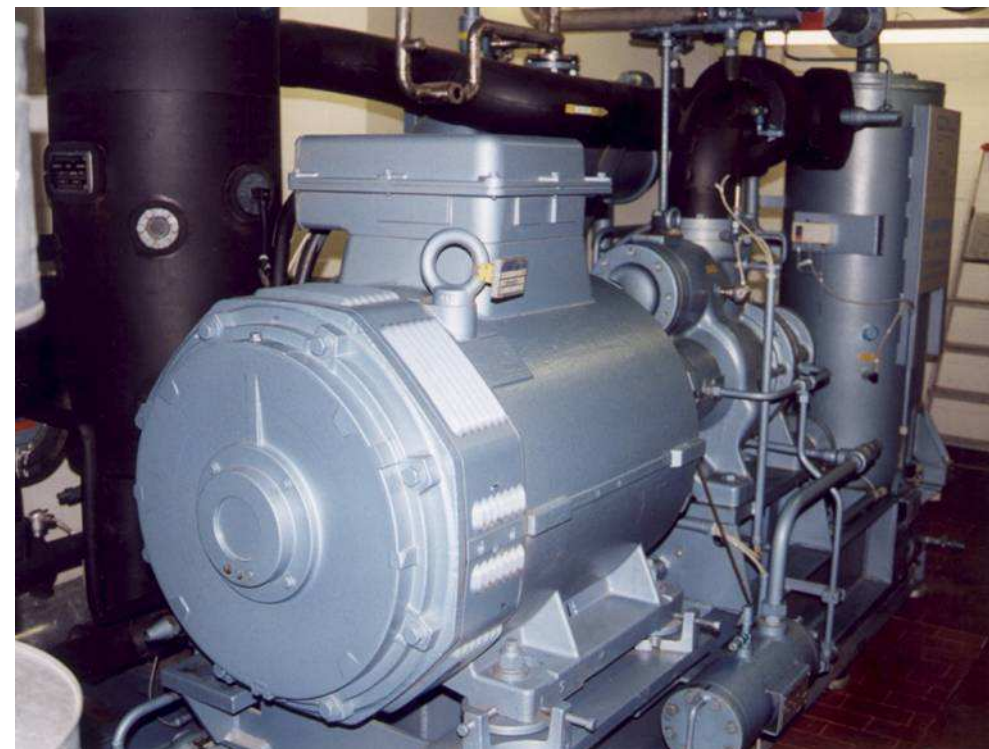
NH 3 Kältezentrale mit 3 x 724 kW Kälteleistung
