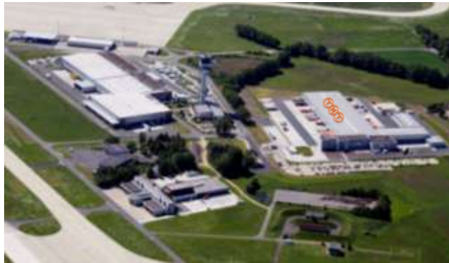
TNT Road Hub im ABP West
