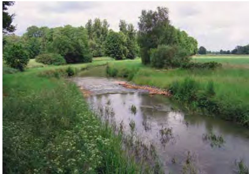
Sohlgleite in der Burgdorfer Aue bei Dachtmissen (Burgdorf)
