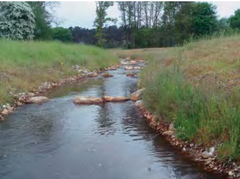
Steinschwellenbeckenpass an der Wietze bei der Mohlmühle (Wedemark)
